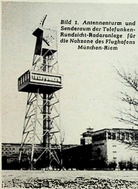
Bild 1. Antennenturm und Senderraum der Telefunken-Rundumsicht-Radaranlage für die Nahzone des Flughafens München-Riem
